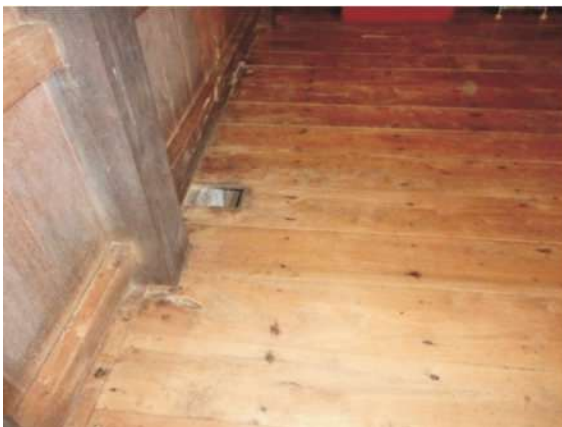
Gambar 4. Deretan pasak pada lantai papan
