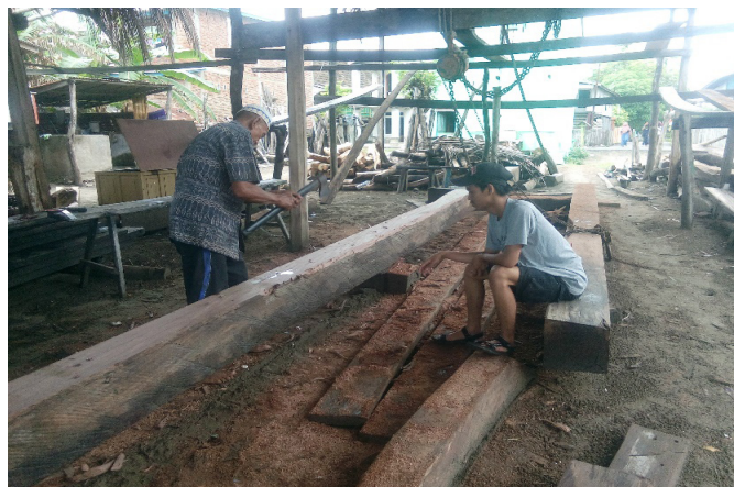
Gambar 3. Proses Pembuatan Lunas Kapal Pinisi
